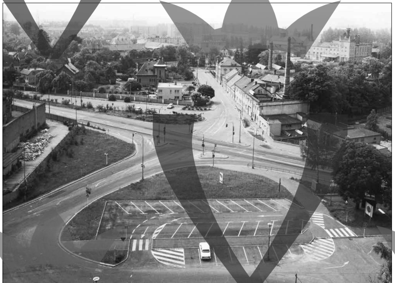
Obr. č. 102: Křižovatka na Pražském předměstí po vybudování nového silničního průtahu, cca 1984
